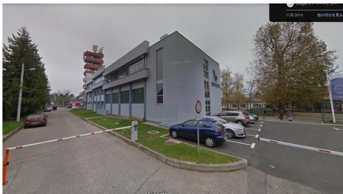
活動場所になっている道場（体育館）。隣に消防署の訓練施設があり、その管理の柔道場とのこと。
